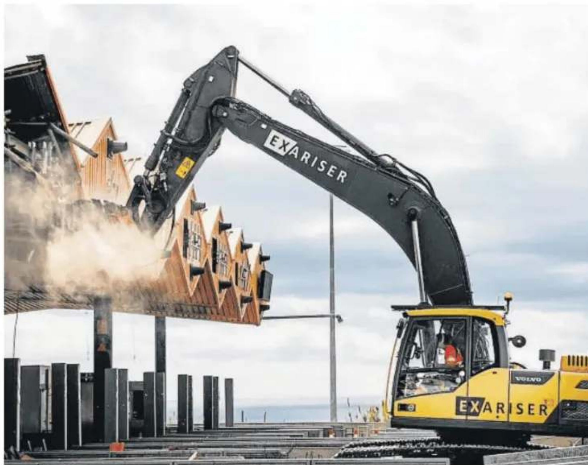
Desmantelamiento de los antiguos peajes en la C-32
