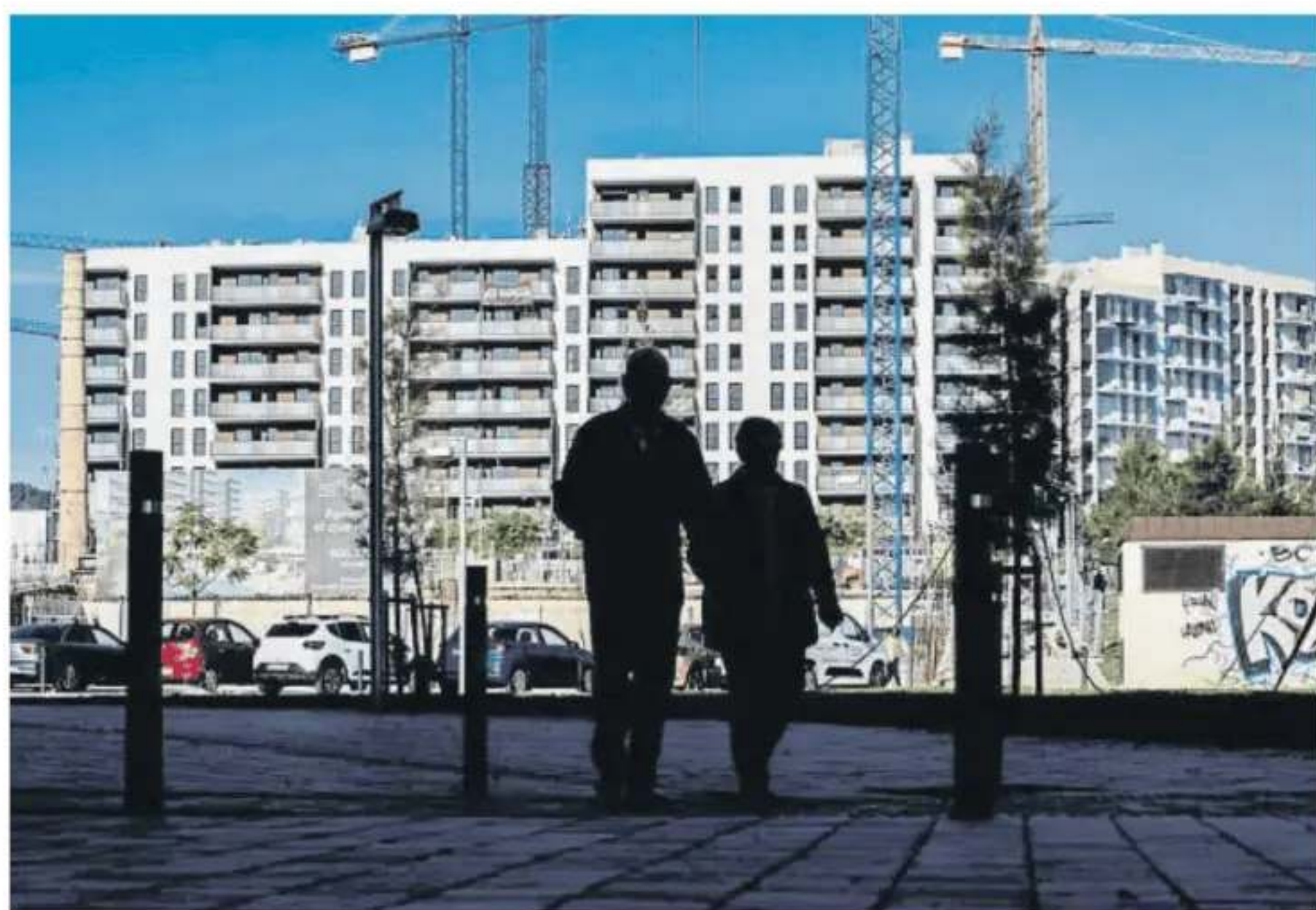
El Govern aboga por que la compra de vivienda se destine solo a uso residencial de particulares
